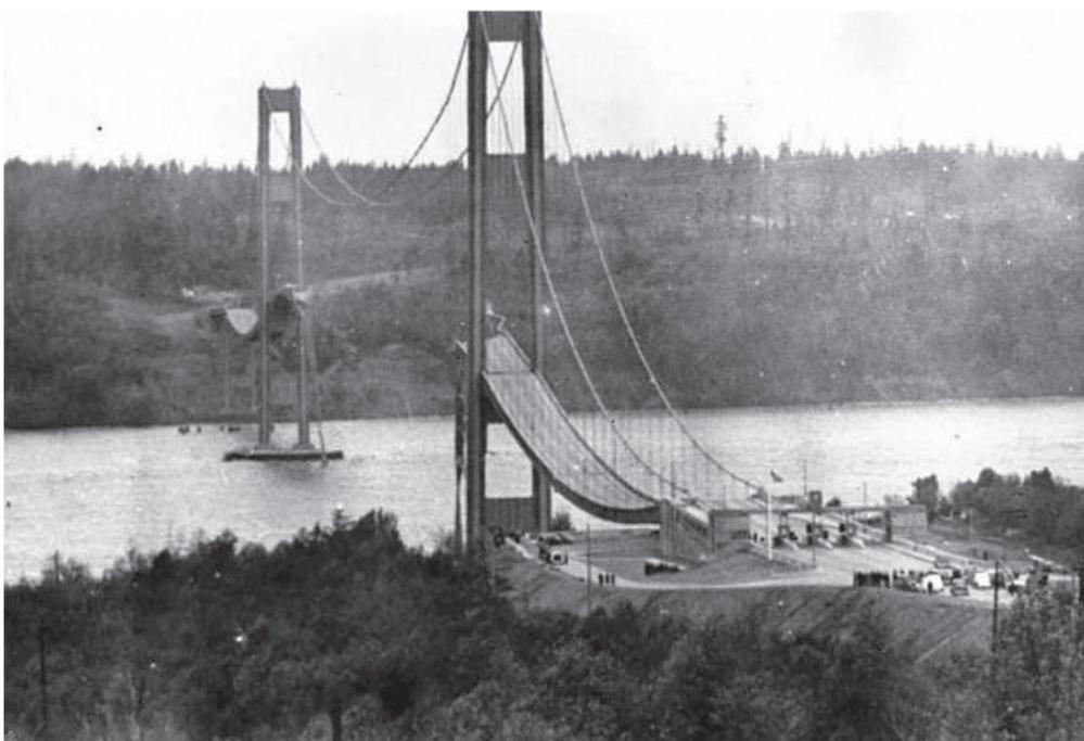
Рис. 5. Разрушение вантового моста в г. Такома, США
